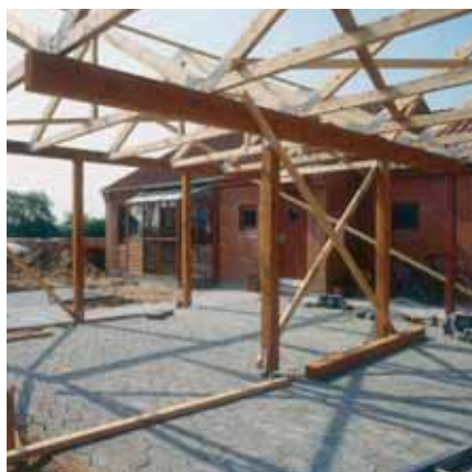
Lærketømmer på byggeplads
