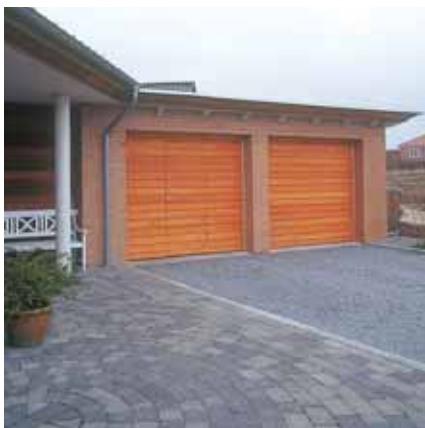
Lærk-klinkbeklædning på porte
