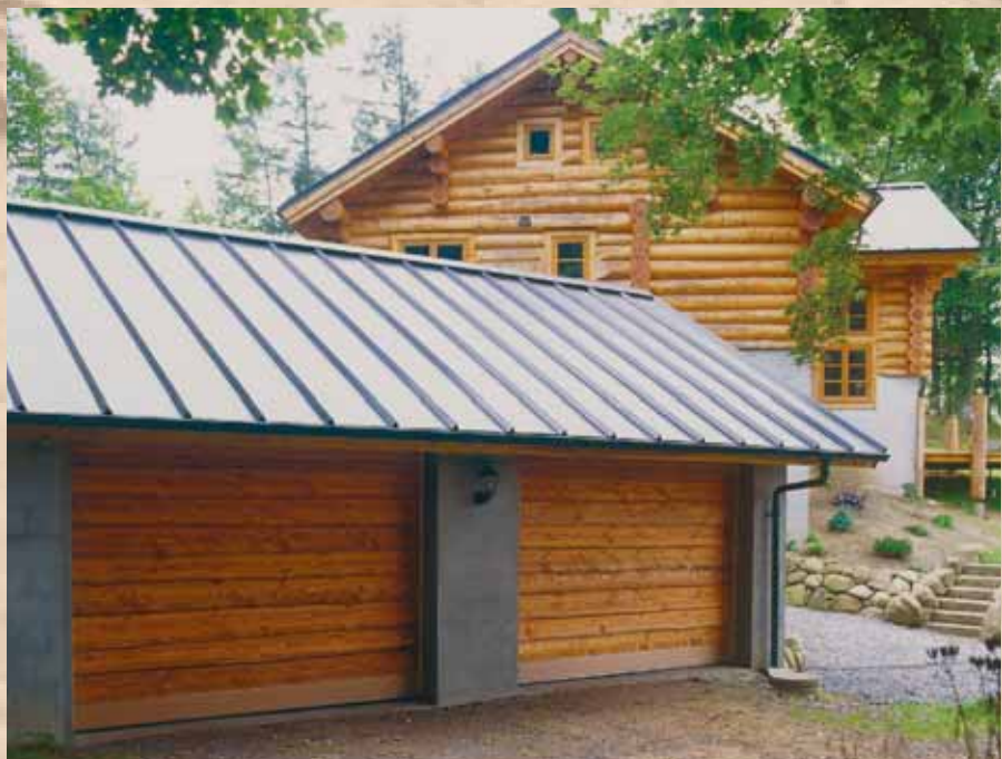
Træ er miljø – porte beklædt med kalmarbrædder i dansk lærk
